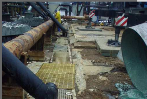
Поврежденные серной кислотой участки бетона
