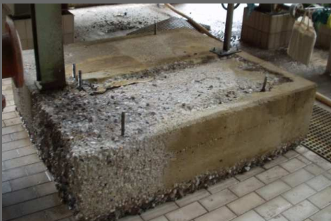
Поврежденные серной кислотой участки бетона
