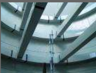
Десульфуризация дымовых газов (FGD) Bekaplast-скруббер
