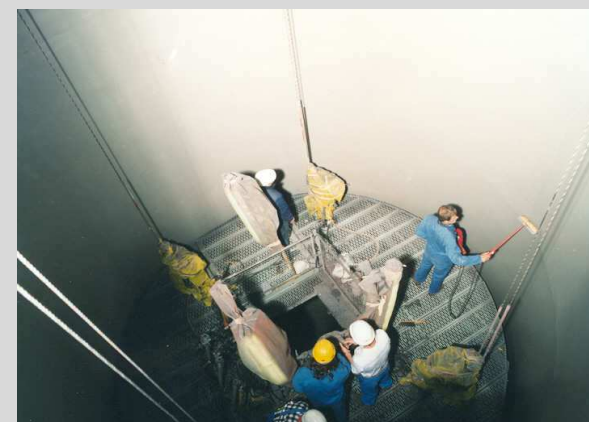
„Spark test“ (per mm thickness etwa 3 KV)
