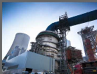
Десульфуризация дымовых газов (FGD) Bekaplast-скруббер
