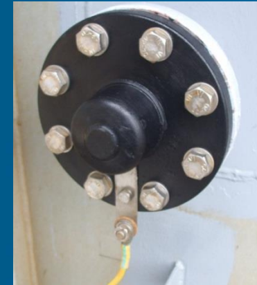
Заземляющие соединения на пучках
