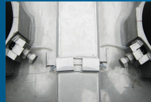
Заземляющие соединения на пучках
